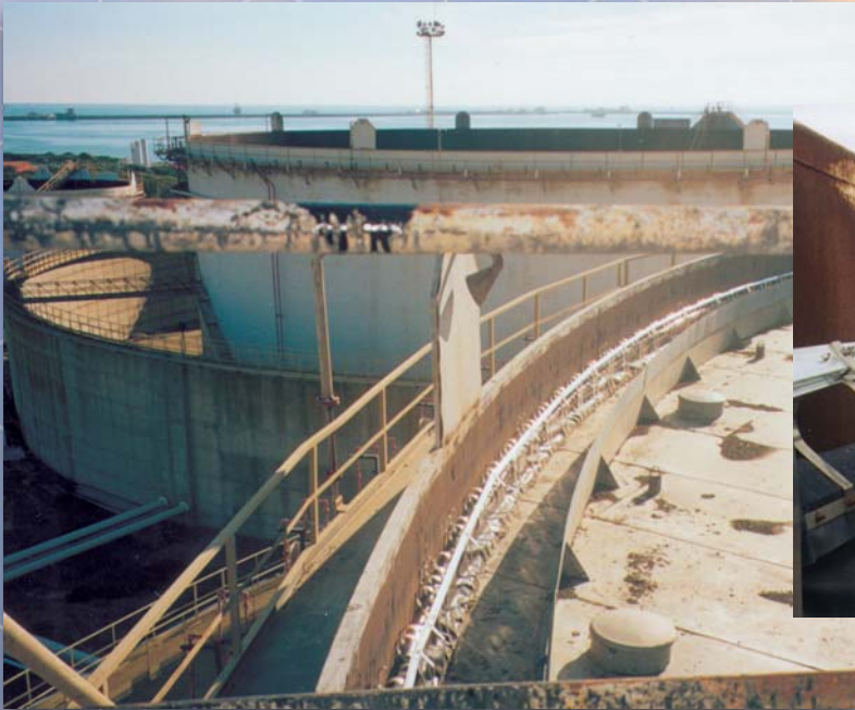
Monitoraggio Temperature superfici esterne Reattori
